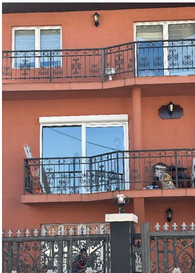
Слика 4.1.3.1. Приказ урађених браварских производа: ограда од челичних цијеви, врата и прозори од PVC профила
