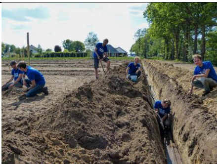
Слика 3. Примјер вјежбе уградње система за наводњавање у засаду ораха
