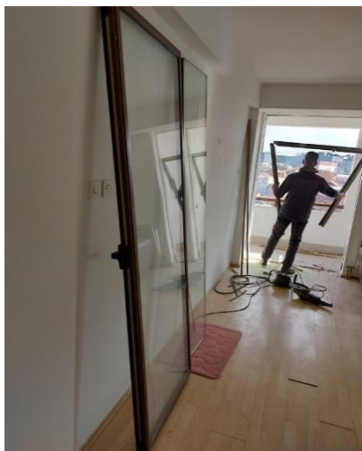
Slika 4.1.1.2. Demontaža prozora i vrata Izvor: Autorski original
