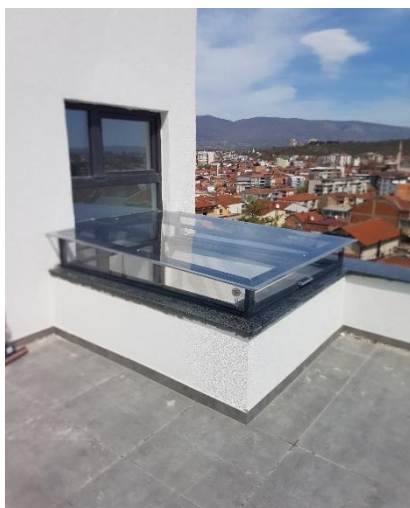
Slika 4.1.1.1. Montirani bravarski proizvod (Poklopac – Nadstrešnica)
