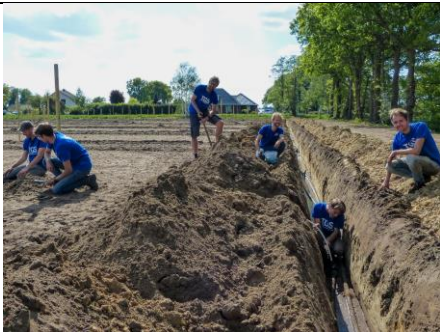
Slika 3. Ugradnja sustava za navodnjavanje u zasadu oraha koju povode učenici
