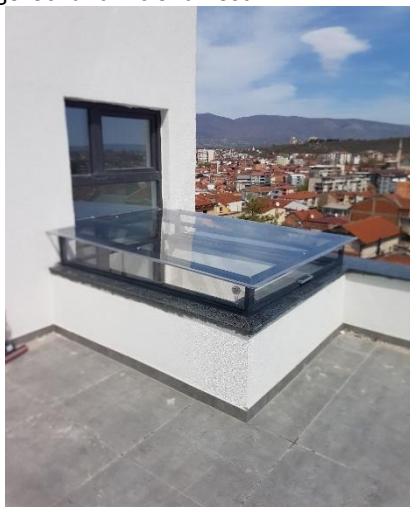
Slika 4.1.1.1. Montirani bravarski proizvod (Poklopac – Nadstrešnica)
