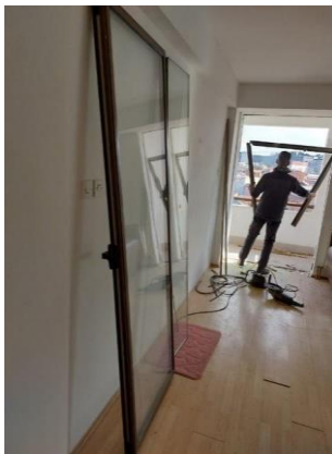
Slika 4.1.1.2. Demontaža prozora i vrata Izvor: Autorski original
