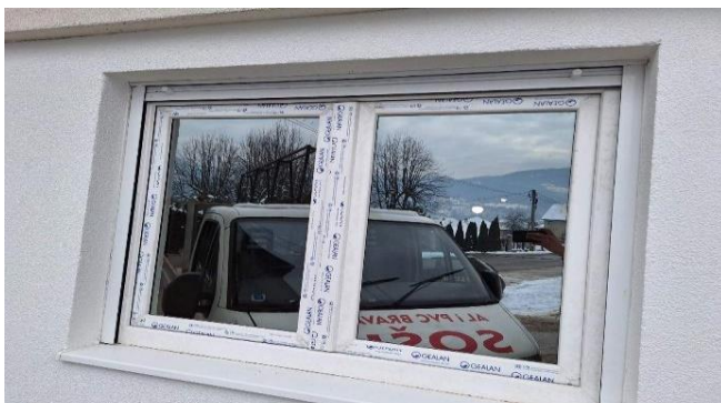
Slika 4.1.2.11. Ugrađeni PVC prozori na mjestima za ugradnju
