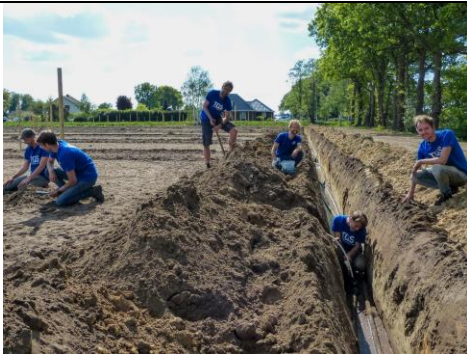
Slika 3. Ugradnja sistema za navodnjavanje u zasadu oraha koju provode učenici
